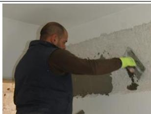
Une première couche de mortier est appliquée sur la surface préparée et pressée fermement. Il faut s'assurer que le profil du support soit rempli sans zone creuse. L'épaisseur de couche devrait comporter 50 - 75 % de l'épaisseur finale souhaitée pour le mortier du système de renforcement.
