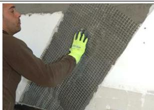
Poser SikaWrap®-350 G Grid sur le mortier frais et le presser légèrement dans la surface de façon à ce qu'une partie du mortier ressorte par les ouvertures du tissu.
