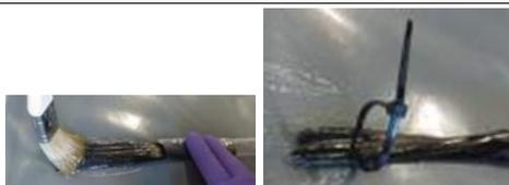
SikaWrap® FX-50 C est imprégné sur les trois quarts de la longueur avec Sikadur®-330 ou Sikadur®-52 Injection tandis que le produit restant reste sec, afin que les fibres puissent être réparties plus aisément. L'extrémité imprégnée est fixée solidement au moyen de colliers de serrage.
