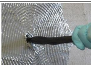
SikaWrap® FX-50 C est introduit lentement à l'aide d'une aiguille à tricoter et les fibres sont réparties régulièrement à la surface du mortier.
