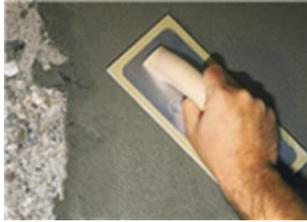
Le traitement de la surface doit être réalisé au moyen d'une lisseuse en bois ou en plastique. La surface du mortier ne doit pas recevoir un traitement de finition avec de l'eau supplémentaire car de cette façon il pourrait se former une structure de surface avec de la laitance de ciment ce qui peut conduire à la formation de fissures à cause du retrait différentiel (fissures capillaires).
