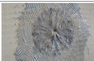
Si elle est recouverte ultérieurement d'un enduit à base de ciment, la résine doit être saupoudrée avec du sable de quartz.
