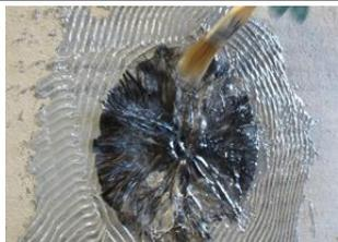
Les fibres réparties sont pressées dans la résine à la surface du mortier et éventuellement imbibées de résine supplémentaire à l'aide d'un pinceau, jusqu'à ce que toutes les fibres soient complètement saturées.
