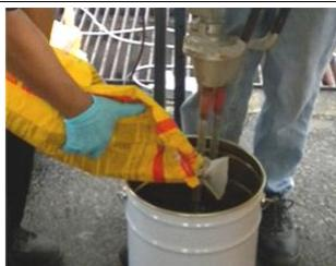
Le rapport de mélange poudre et eau doit être ajusté selon la température et les conditions d'application tout en tenant compte de la durée de vie en pot du mortier.
