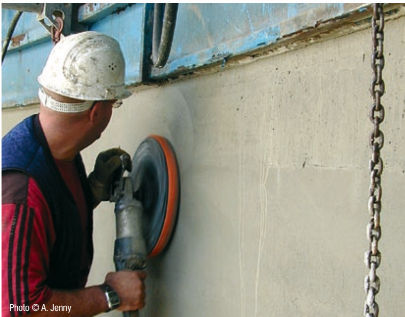
Zum Schliessen der Luftporen wird die Betonoberfläche mittels Glattscheibe bearbeitet.
