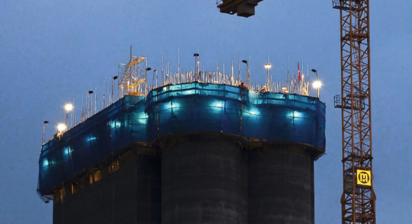
Gearbeitet wird in grosser Höhe und bei engen Platzverhältnissen. Die Scheinwerferbeleuchtung zeugt vom 24-Stundenbetrieb.
