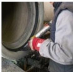
Pour le collage de joints d'étanchéité dans les gaines de raccordement
