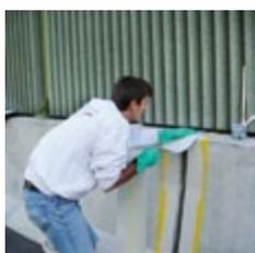
Etanchement de joint extérieur collé
