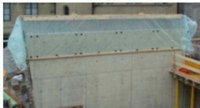
Fig. 22: Protection contre les coulées de rouille
