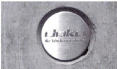
*Fig. 11: Fermeture d'un trou d'écarteurs de coffrage avec un cône en acier inoxydable et gravure*
