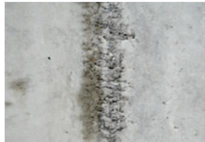
*Fig. 24: Divergences de couleur à l'endroit d'un joint de reprise non étanché*
