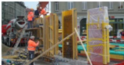
Fig. 21: Protection des arêtes et protection contre les salissures
