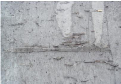
*Fig. 23: Résultats d'une surface de coffrage défectueuse*
