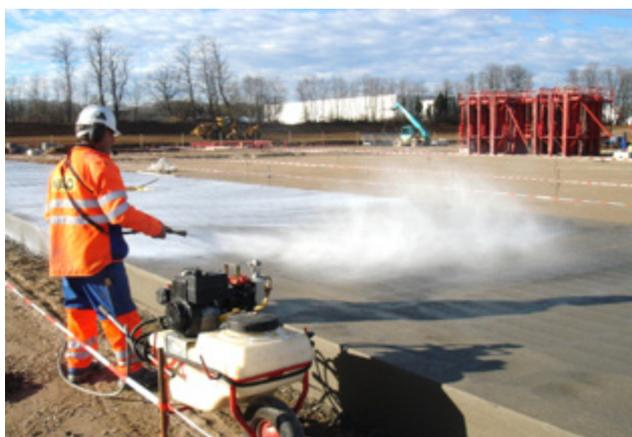
Per accrescere ulteriormente la qualità della superficie in calcestruzzo si possono cospargere sostanze dure.
