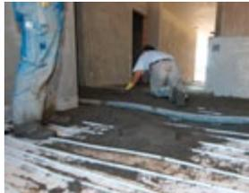
mene Dröhnen beim Begehen des Zementestrichs kann so erfolgreich reduziert werden. Der Estrich weist durch seine Masse eine optimale Wärmespeicherfähigkeit auf. Ausserdem sind zementgebundene Systeme was-serunempfindlich.
