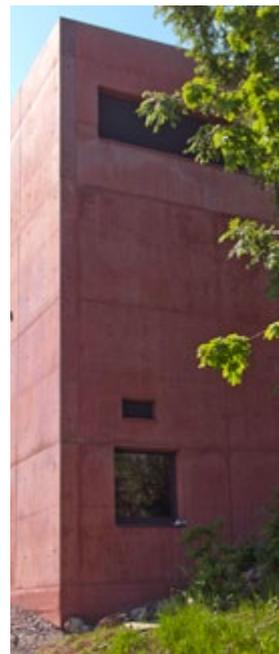
folgenden Eigenschaften verwendet: C30/37, XC4, CI 0,10, Dmax32, C3. Die Einfärbung erfolgte mittels einer kundenspezifischen Pigmentmischung, dem Sika® ColorCrete-G Colormix.
