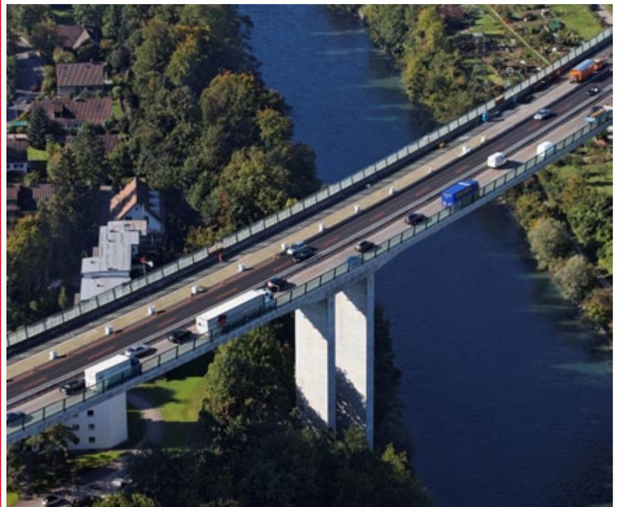
Elemente ist das Felsenauviadukt. Das 1972–1974 erbaute und durch den bekannten Brückenbauer Christian Menn mitprojektierte Bauwerk weist eine Länge von etwa 1,1 km auf und überspannt die Aare in einer Höhe von rund 60 m. Es handelt sich um die grösste Autobahnbrücke der Schweiz mit dem grössten Verkehrsaufkommen des gesamten Schweizerischen Nationalstrassennetzes (> 100 000 Fahrzeuge / Tag).
