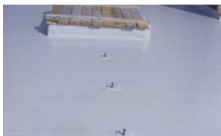
L'intégration d'un maillage de paratonnerre avec les supports, qui sont directement soudés sur l'étanchéité.
