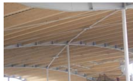
Vue de la structure porteuse du toit et l'ossature.
