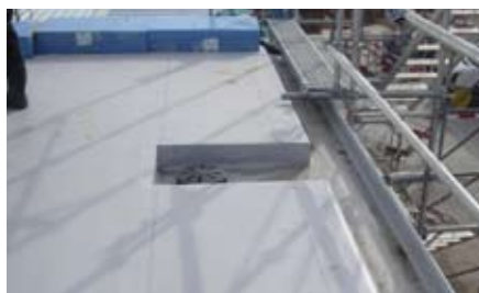
Chéneau et naissance encaissés.
