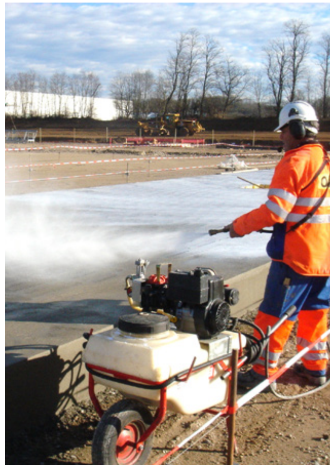
Traitement de cure avec Sika® Antisol® E-20
