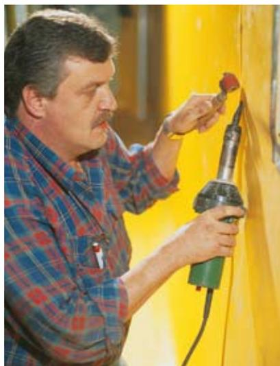
Lavorazione semplice e sicura del Sarnafil G 465-15 con saldatura ad aria calda.
