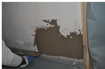
Appliquer régulièrement le coulis d'étanchéité prêt à l'emploi en 2 passes de travail au minimum, dans une même consistance et épaisseur de couche (env. 1 - 2 mm par couche), au moyen d'une truelle (éventuellement aussi au pinceau ou au rouleau). Les épaisseurs de couche doivent aussi impérativement être respectées vers les angles et les arêtes.
