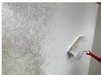
Appliquer la résine avec un rouleau approprié jusqu'à ce que toutes les fibres de verre soient mouillées. Choisir l'orientation du rouleau pendant l'application de manière à ce qu'aucun pli ne soit formé dans le tissu.
