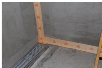
Étancher les angles intérieurs et les raccords sol/paroi avec la bande Sika® SealTape B.
