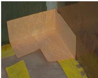
Etanchéité des angles intérieurs et des raccords sol/paroi avec Sika® SealTape B.
