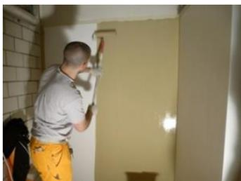
Suivant le pouvoir couvrant, appliquer le revêtement pigmenté Sikafloor®-302 W+ (coloré) en 2 - 3 fois. Ponçage possible entre les couches avec du papier 220 & 500. **Consommation:** Env. 0.1 kg/m<sup>2</sup> par passe de travail. Jointoyage des angles intérieurs au moyen d'un mastic d'étanchéité pour joints approprié p.ex. Sikaflex® PRO-3.
