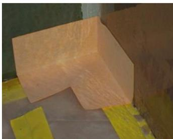
Etanchéité des angles intérieurs et des raccords sol/paroi avec Sika® SealTape B. Vers les pénétrations, coller la bande Sika® SealTape B avec le tuyau traversant au moyen de SikaBond® AT-44 R.
