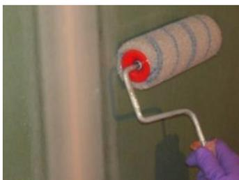
Sur la préparation du support adaptée au matériau de construction. Couche de fond/égalisation préalable sur toute la surface avec Sikafloor®-701. Suivant le matériau de construction, les joints doivent être spatulés. (voir chapitre 5.5.2).
