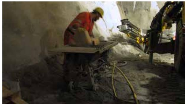
Consolidation temporaire de l'excavation avec du mortier projeté par voie sèche
