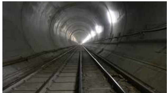
Béton de l'anneau intérieur comme construction durable des deux tubes principaux
