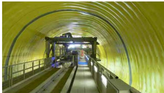
Systèmes d'étanchéité durables appliqués après la consolidation par béton projeté et avant la construction de l'anneau intérieur en béton
