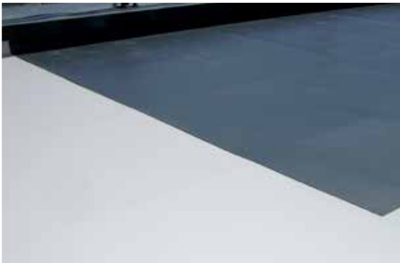
Die Recycling-Schutzbahn schützt die Dachabdichtung vor mechanischen Einflüssen.
