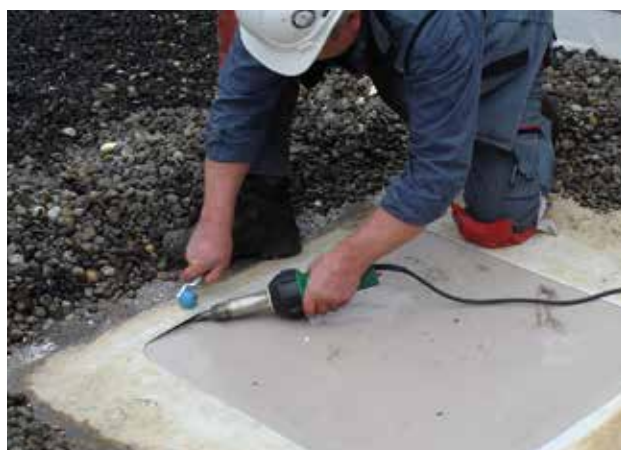
Sichere Verschweissung mit Neumaterial
