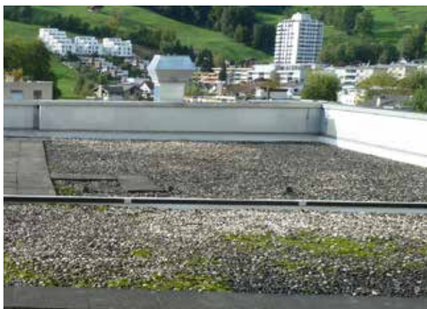
Erstes Sarnafil T Dach in Europa: Sarnen 1988
