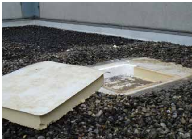
Dachaufbau komplett trocken
