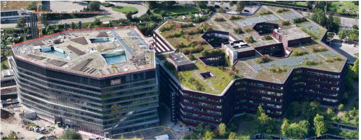
Rechts: über 20-jähriges Sarnafil-Dach | Links: neues Sarnafil-Dach
