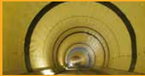
ABDICHTEN IM ERDREICH / GEWÄSSERSCHUTZ
