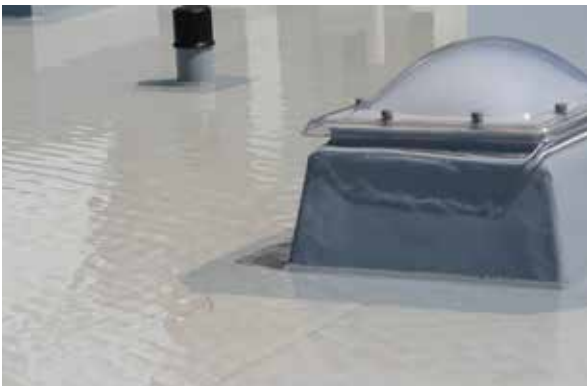
Zusätzliche Sicherheit für die Kontrolle der Dichtigkeit bietet die Wässerung bei der Dachabnahme.
