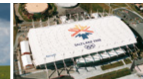
Hochreflektierende Dachmembranen vermindern den Kühlungsbedarf und erhöhen die Effizienz von Solarpanels
