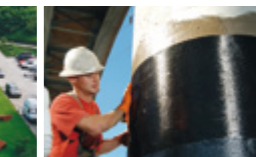
Verbundsysteme für die Verstärkung älterer Strukturen (z.B. Brücken) und die Verlängerung ihrer Lebensdauer
